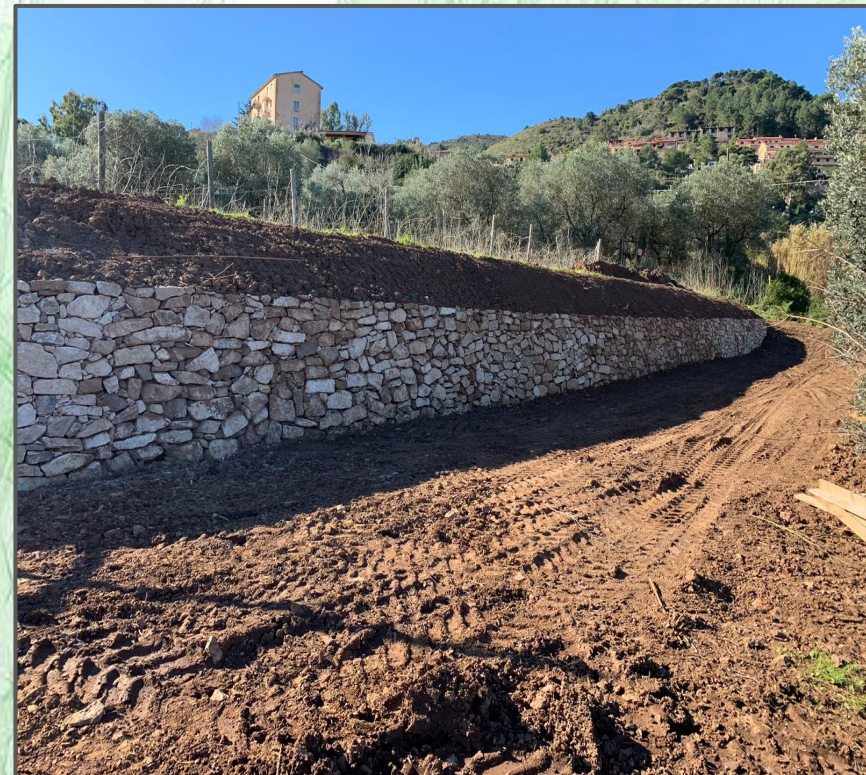
Sistemazione con muro a secco
