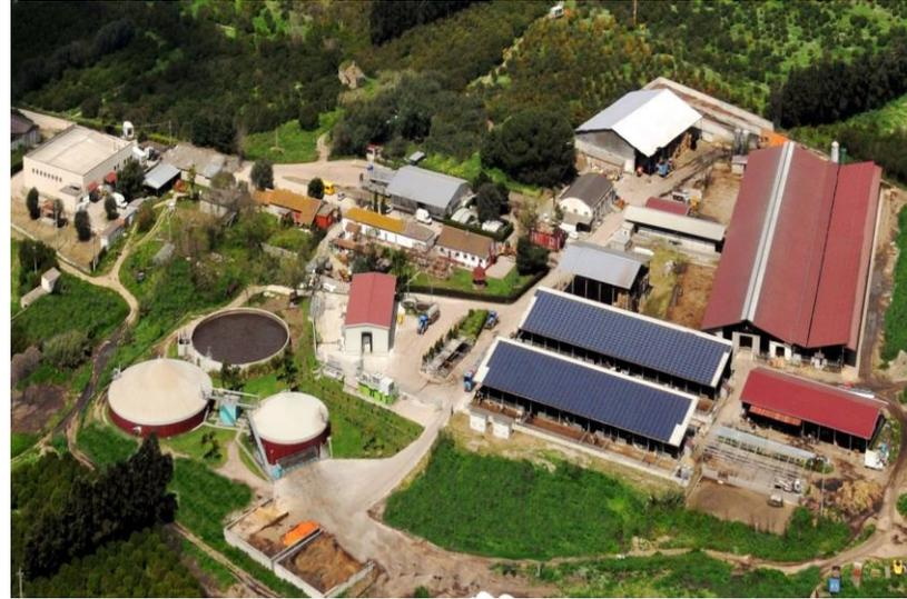
Il biogas così prodotto viene bruciato in un cogeneratore, un motore che produce energia elettrica ed energia termica. L'energia elettrica prodotta è in grado di soddisfare il fabbisogno di 2680 famiglie, e l'energia termica viene utilizzata per i processi produttivi del caseificio, consentendo di risparmiare combustibili fossili.
