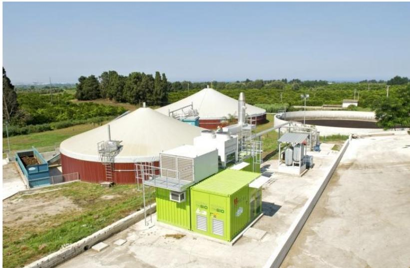
Il letame e il liquame provenienti dalle loro stalle, unitamente al siero che rimane come residuo dalle lavorazioni del caseificio, vengono raccolti in due fermentatori, all'interno dei quali, grazie alla tecnologia di miscelazione e riscaldamento, avviene un processo di fermentazione anaerobica che produce biogas, un gas biologico che contiene una percentuale del 55% di metano.
